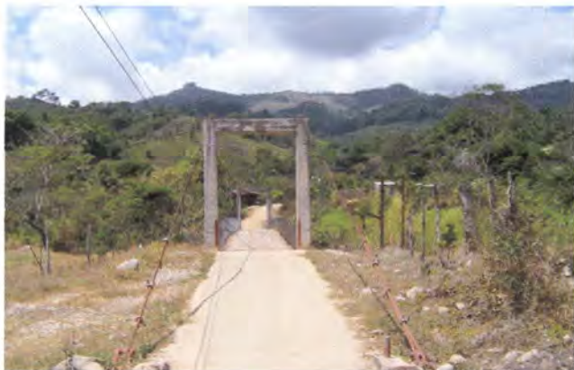
Fotografía 9. La reparación de caminos y la construcción de puentes, fue una de las principales tareas del Concejo de Distrito de Rivas, donde los daños ocasionados por el Río Buena Vista fueron cuantiosos.
