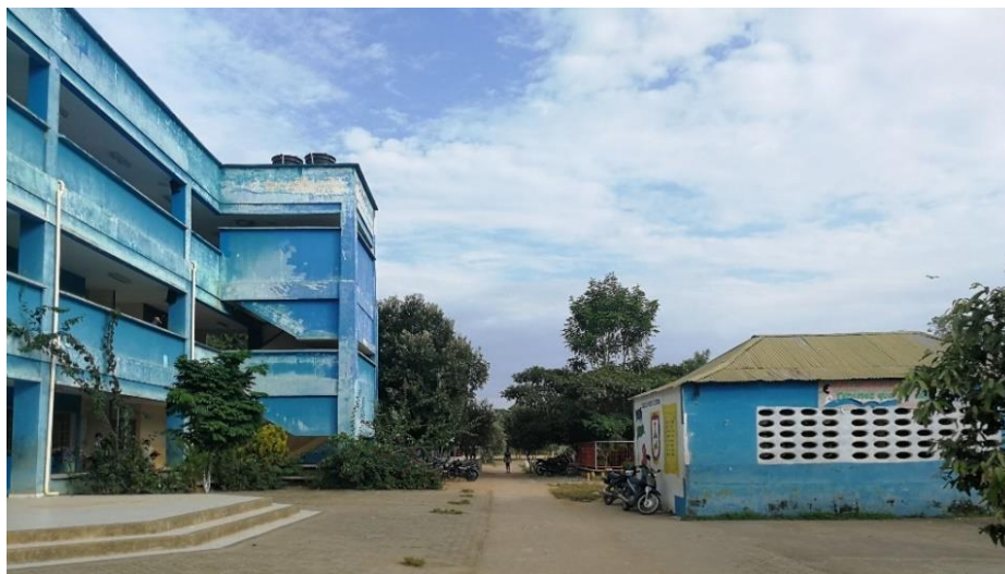
Figura 14. Crecimiento infraestructura Colegio Belén, en la parte derecha de la imagen se observa la primera aula de la Escuela rural, en la parte izquierda, se observa la construcción del bloque de aulas en aras de la cobertura educativa que tuvo la Escuela a raíz de la llegada de la población desplazada a la zona. Fuente: Jessica Otero
