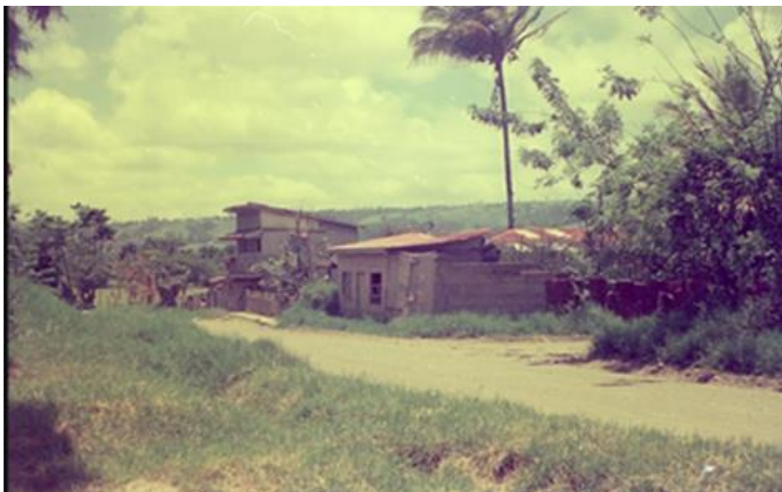
Figura 38. Casas en el centro de comunidad de Arenal antes del desplazamiento
