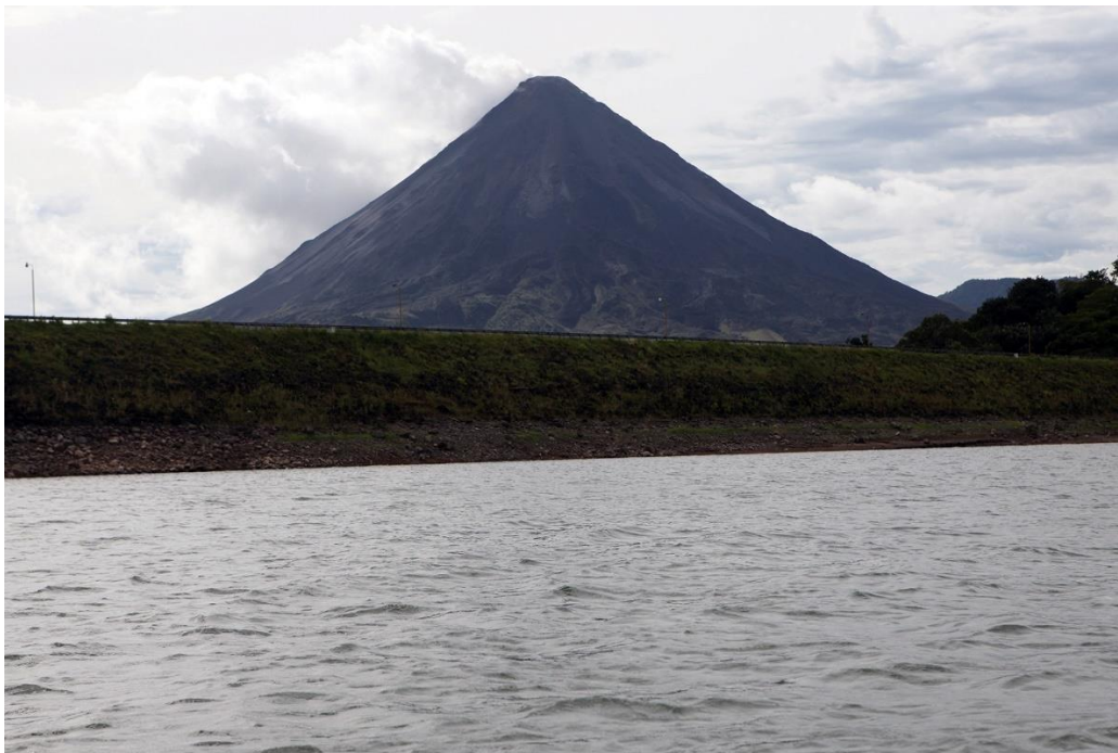
Figura 16. Embalse del Proyecto Hidroeléctrico Arenal 2019
