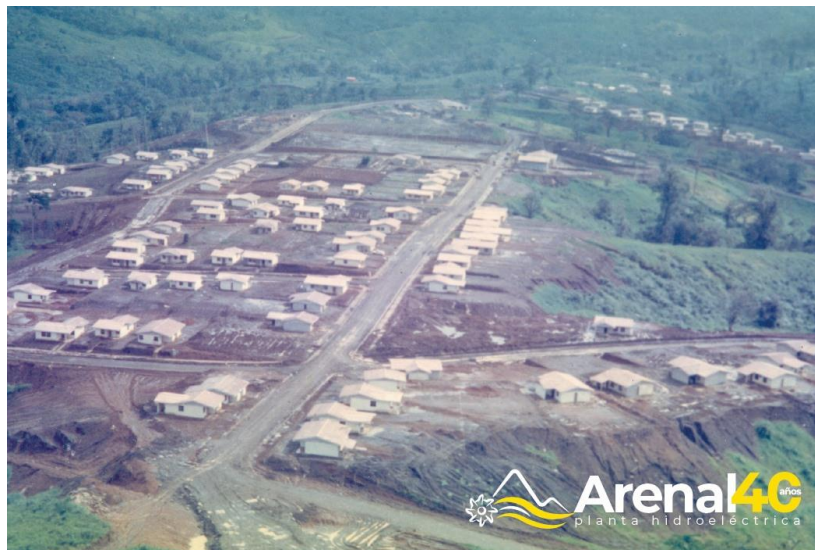
Figura 52. Aspectos constructivos del emplazamiento constructivo del sitio de reasentamiento de Arenal
