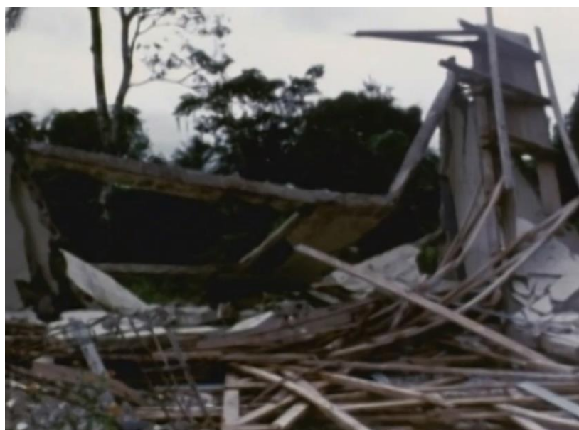
Figura 45. Desarme de las viviendas con el fin de recuperar la familia los materiales
